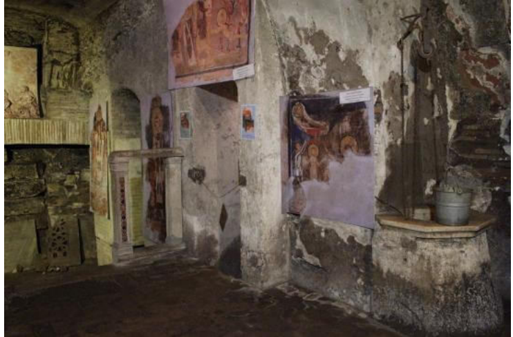
Figura 9 - Stato della cripta circa anni '90 del secolo scorso, prima dei distacchi parietali e restauri, ora alla Cripta Balbi
