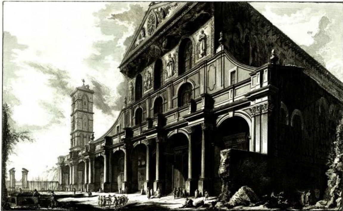
Figura 21 - Veduta della facciata della Basilica di San Paolo fuor delle mura – G. B. Piranesi, Parigi 1768 - Evidente il campanile , demolito in occasione della ricostruzione
