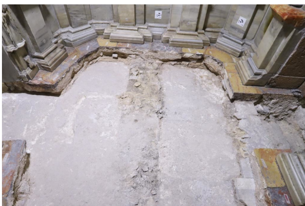
Il banco di roccia sotto la pavimentazione nella cappella dell'Angelo
